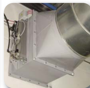
VALVULAS VALSEC INSTALADAS EN CIRCUITOS DE TRANSPORTE NEUMATICO
